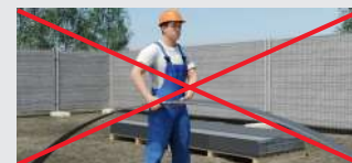
A Hardie® VL Plank homlokzati lemezek egymásba illesztve kerülnek kiszállításra. A paneleket a raklapról való kivételkor oldalirányban kell kihúzni, és csak ezután szabad felemelni.
