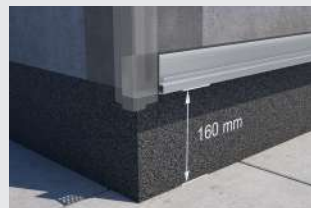
Indítóprofil rögzítése
