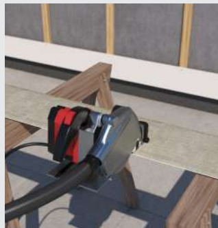
Szálcement vágáshoz alkalmas fűrészlapot kell használni (ajánlott: Hardie™ Blade fűrészlap).
