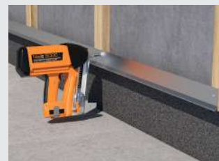
A lábuzati szellőzőprofil rögzítése.
