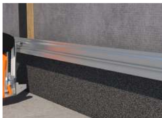
A kezdőprofil rögzítése.
