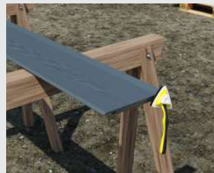
A Hardie™ Seal él impregnáló felvétele a szerelés előtt.
