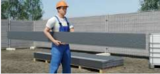
A termékeket szereléskor mindig állítva kell szállítani.
