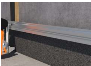
A kezdőprofil rögzítése.
