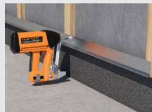
A lábazati szellőzőprofil rögzítése.
