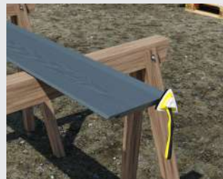
A Hardie™ Seal él impregnáló felvitele a szerelés előtt.
