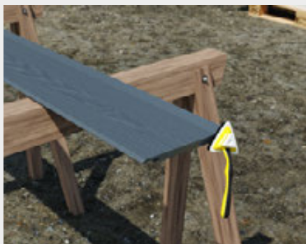
Auftragen der Hardie™ Seal Kantenversiegelung vor der Montage.
