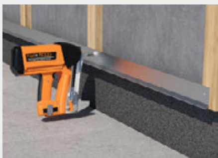
Befestigung des Sockel-Lüftungsprofil.
